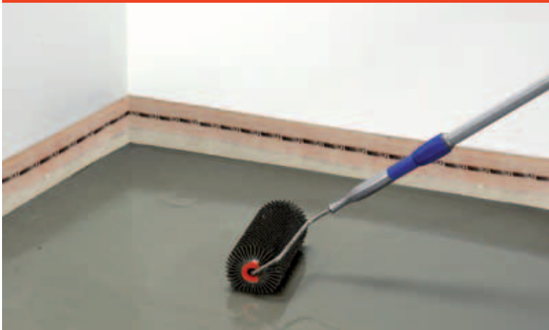
Obr. 32: Dodatočné spracovanie zalievacej hmoty
