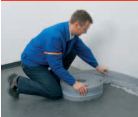
Obr. 2: Pokládka okrajového izolačného pásu
