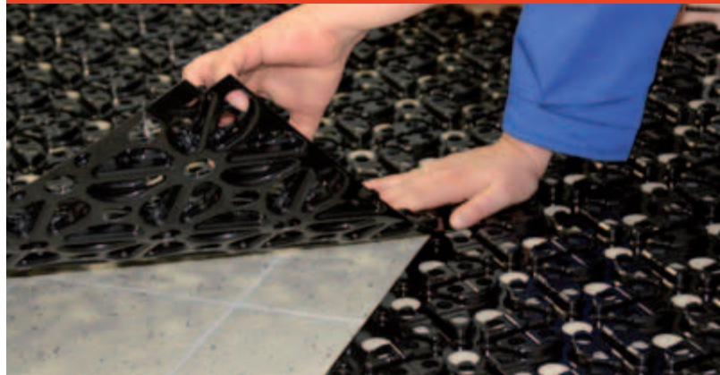
Obr. 29: Tvarové uloženie systémovej dosky
