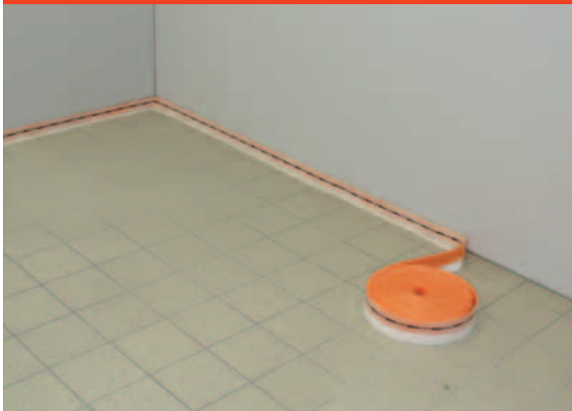
Obr. 26: Uloženie okrajového pásu
