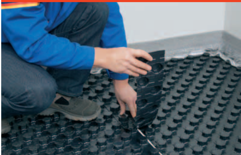
Obr. 6: Nopový prvok narežte „na mieru“
