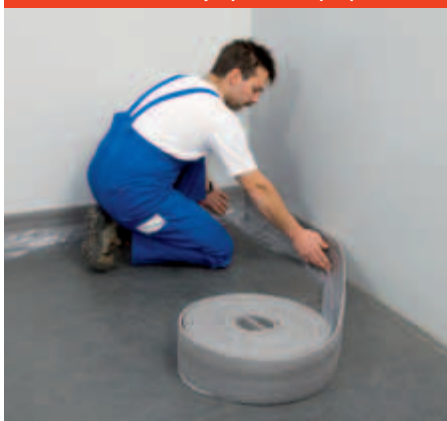
Obr. 14: Pokládka okrajových izolačných pásov
