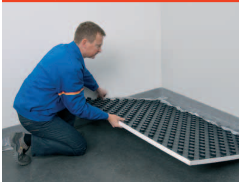
Obr. 4: Pokládka nopového prvku
