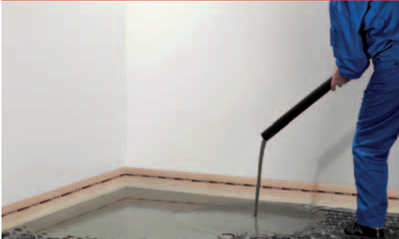
Obr. 31: Nanesenie zalievacej hmoty
