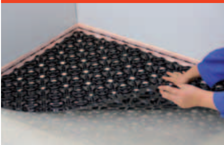
Obr. 28: Uloženie prvej systémovej dosky
