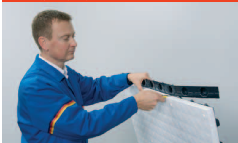
Obr. 3: Fóliový presah nopového prvku treba odrezáť
