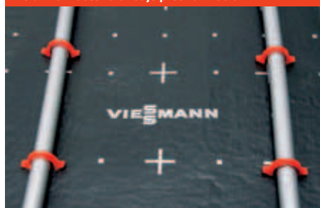
Obr. 18: Raster uľahčuje presnú fixáciu
