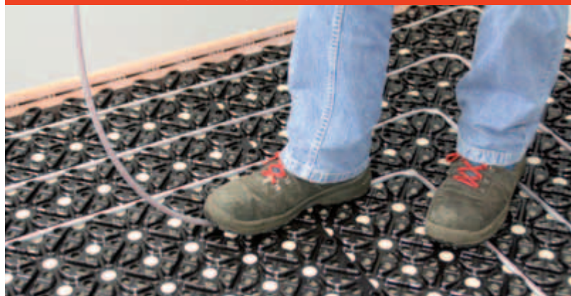
Obr. 30: Pokládka Vitoset bezpečnostnej rúry
